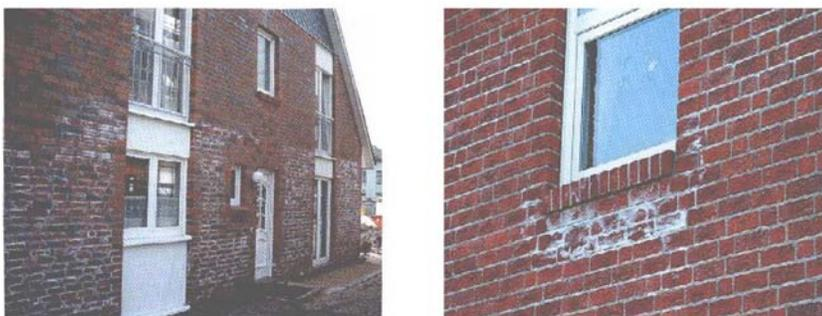
**Рис. 17, 18** Дефекты фасада из-за ошибок при устройстве гидроизоляции
