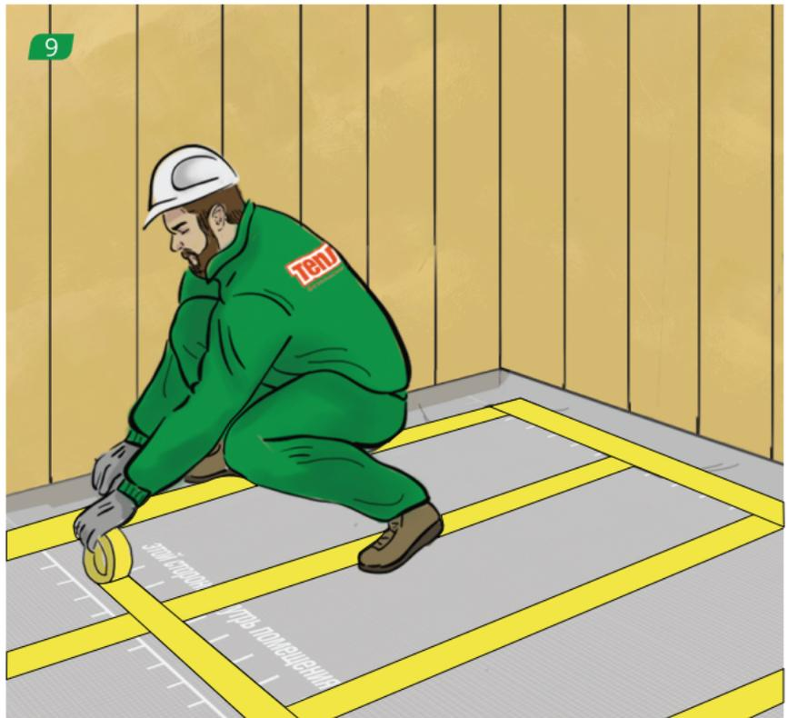
Стыки и места крепления пленки проклеиваем лентой для проклейки швов. Пароизоляция, уложенная на стене, должна быть проклеена с пароизоляцией, раскатанной на полу, для создания герметичного контура.
