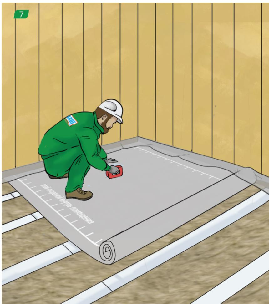
Поверх утеплителя поперек балок раскатываем пароизоляционную пленку и фиксируем ее по балкам степлером. Каждый последующий слой – с нахлестом 10-15 см.
