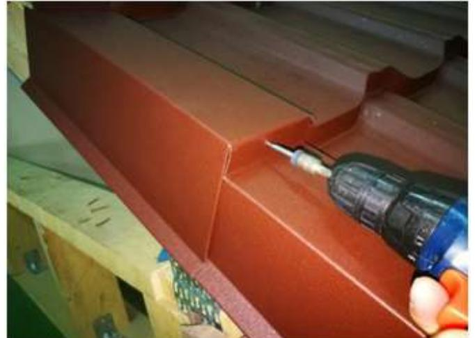
7. Зафиксируйте планку саморезом 4,8x29 или 4,8x35 в нижнюю ступеньку листа металлочерепицы. Саморез должен пройти через нижний отгиб верхней планки, верхний отгиб нижней - в ступеньку листа.
