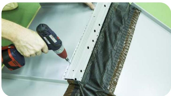
Закрепите между замками панелей Кликфальц® планку вентпрогона опорного на кровельные саморезы.
