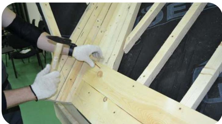
Для монтажа обрешетки используйте доски толщиной 25 мм с влажностью не более 20%, (при межстропильном расстоянии <700 мм допускается толщина 20 мм).
