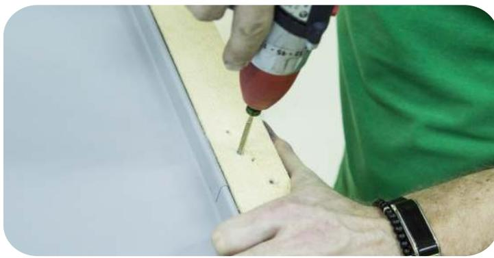
Уложите брусок высотой 30 мм и шириной 50 мм поверх кляммера параллельно картине. Закрепите брусок.
