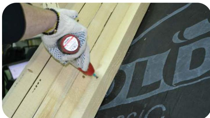
Поверх гидроизоляционного материала на стропила смонтируйте контрбрус.
