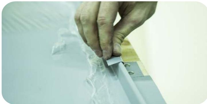
Закрепите подготовленную панель саморезами с прессшайбой, а также самодельными кляммерами по линии торца.
