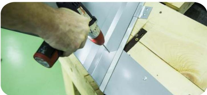
Зафиксируйте крепежную планку с помощью вытяжных заклепок по обеим сторонам вдоль линии ендовы, не ближе чем 150 мм к центру ендовы.
