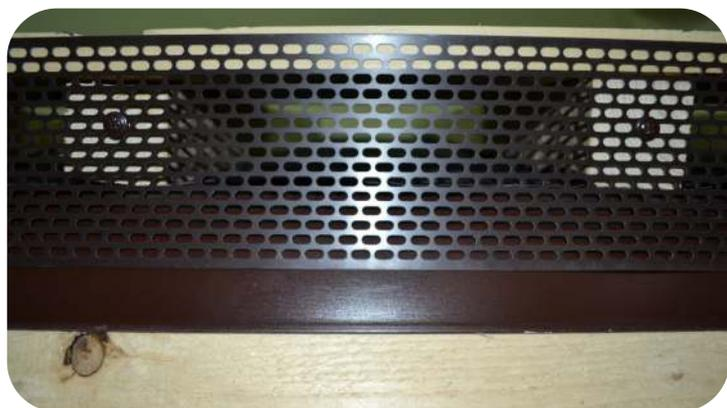
Зазор между капельником и доской начальной обрешетки необходимо закрыть карнизной лентой для защиты подкровельного пространства от насекомых и птиц.
