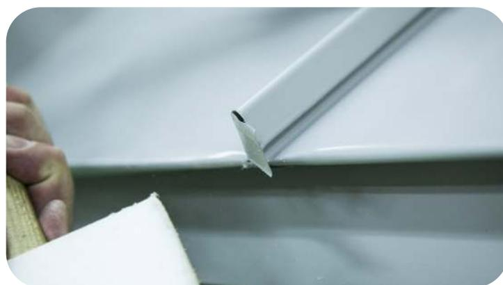
Несрезанной частью верхнего замка закройте торец замка и обрежьте по его контуру. Последующие картины монтируются аналогично.
