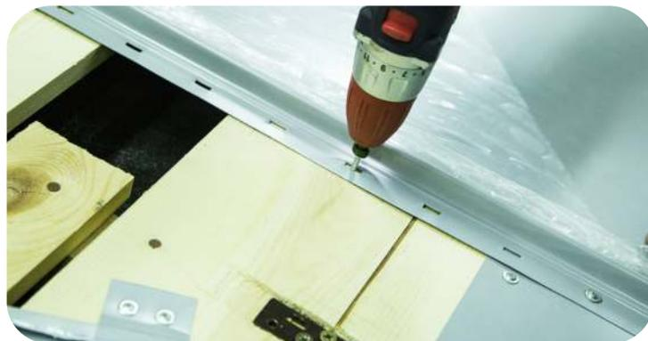
Вкручивайте саморезы строго под углом 90° к обрешетке, избегайте перетягивания саморезов. Перетянутые саморезы будут препятствовать тепловому расширению картин, а саморез, закрученный под углом, может помешать креплению следующей картины. Эти нарушения могут привести к появлению деформаций.
