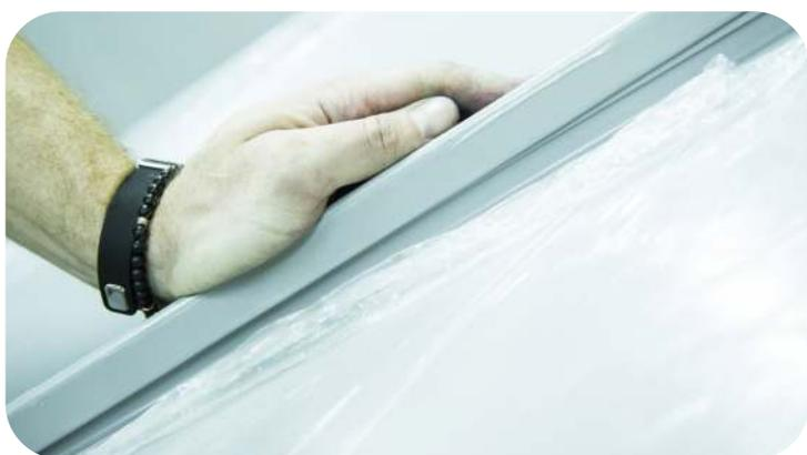
Подготовленную панель установите на скат, оставив зазор 5 мм. между карнизной планкой и загибом панели, защелкните замок. Используя брусок и киянку, выровняйте панель относительно первой.
