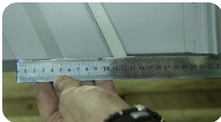
Отметьте линию загиба картины на карнизе на расстоянии 25 мм от края. Замерьте расстояние от замка уже смонтированной картины до края крепежной планки и перенесите на линию загиба.
