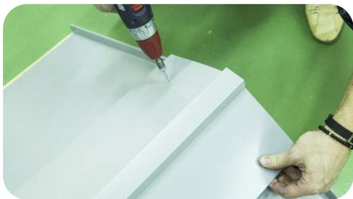
Закрепите конек 150x40x150 к планке вентпрогона опорного кровельными саморезами.
