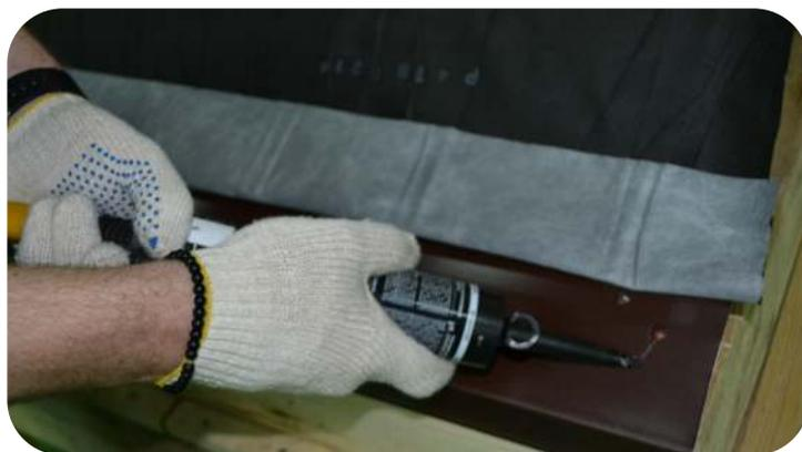
На капельнике закрепите материал при помощи двустороннего скотча или клея-герметика.
