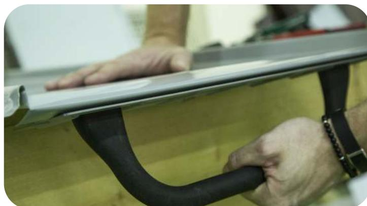
Загните подрезанный край картины внутрь с помощью инструмента для загиба карнизного свеса. Проконтролируйте угол загиба, он должен составлять 15-30°.
