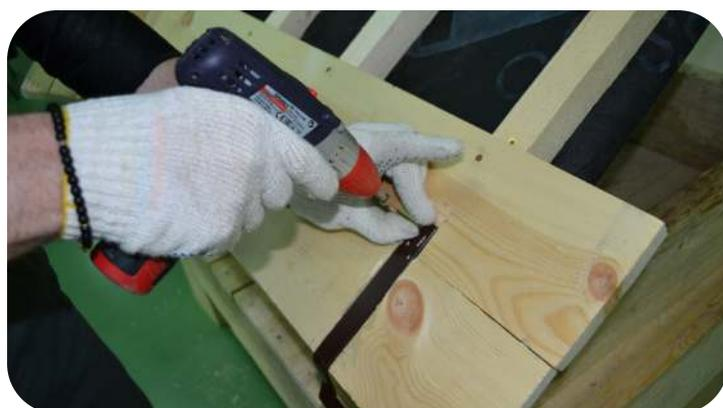
Закрепите подготовленные крюки водосточной системы в пазах оцинкованными саморезами с шагом, рекомендованным производителем. Ни крюки, ни саморезы не должны выступать выше обрешетки.
