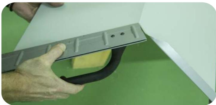
Вдоль линии карнизного свеса на планке ендовы сделайте загиб на 180° длиной 25 мм. Загиб обеспечит плотное прилегание планки ендовы к карнизу без крепления саморезами.
