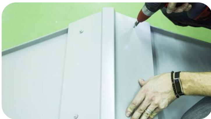
**Внимание!** Не перетягивайте коньковые саморезы! Настройте шуруповерт так, чтобы при окончательном прижатии конька к вентпрогону резиновая прокладка была слегка сжата. Следите, чтобы после крепления коньковой планки саморезами, планка оставалась ровной без прогибов.
