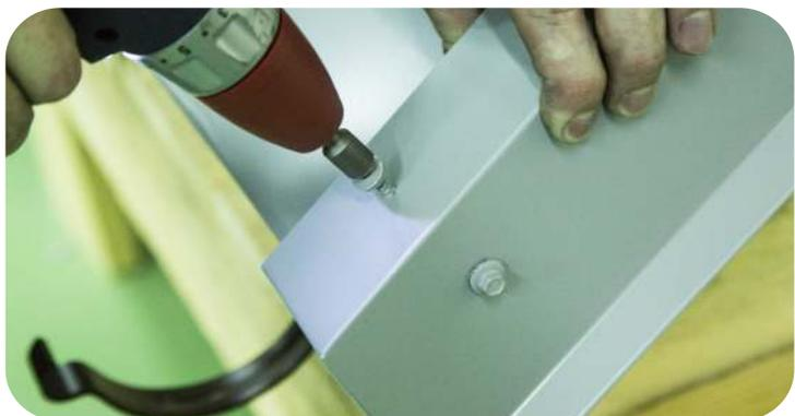
Уложите торцевую планку на брусок и закрепите кровельными саморезами в верхнюю и торцевую часть с шагом 500 мм. Сделайте загиб на краю торцевой планки так, чтобы закрыть торец бруска.
