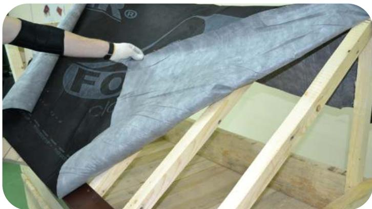
На стропила уложите гидроизоляционный материал, закрепив к стропилам строительным степлером.
