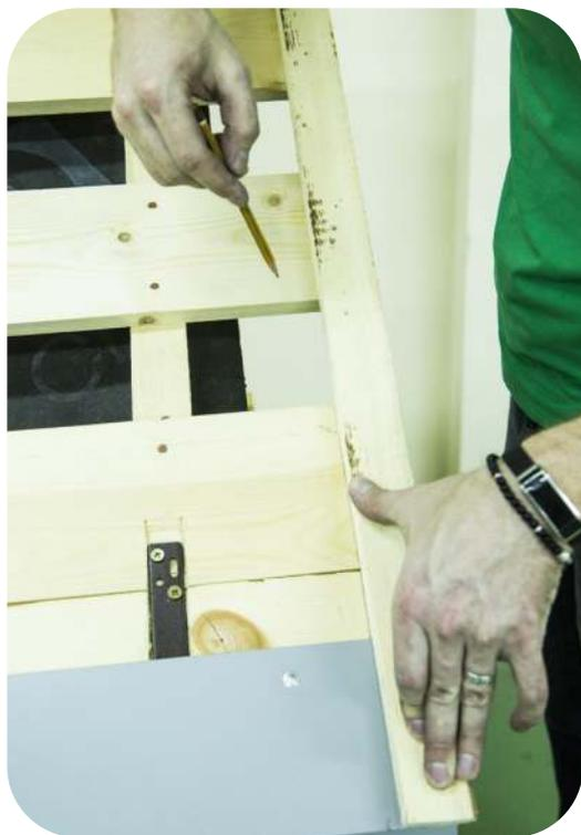
Для симметричного расположения картин на скате, а также при отсутствии прямого угла между линиями карниза и торца, картины, примыкающие к торцам, иногда требуется обрезать вдоль торца.
