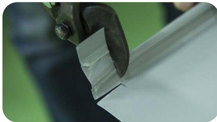
Подготовьте панель для монтажа на карнизе. Для этого сделайте надрезы глубиной 25 мм у замка и на обрезанном крае. Срежьте нижний и верхний замки для формирования загиба панели на карнизе.
