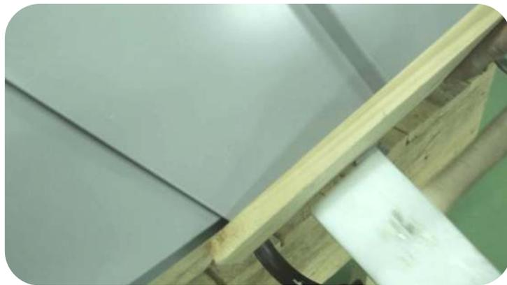
Подготовленную панель Кликфальц® установите на скат, защелкните замок.
