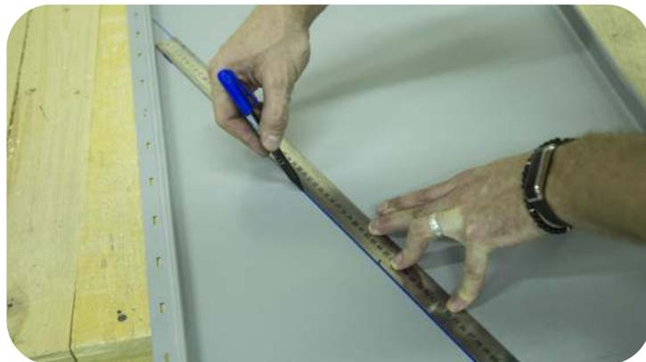
Из деревянных брусков скотите шаблон. Зафиксируйте на шаблоне угол между линией ендовы и картиной. Используя шаблон, перенесите на панель линию отреза.
