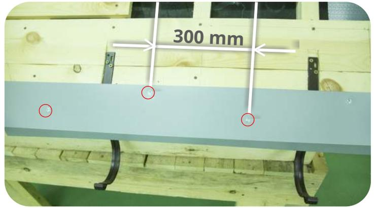
Поверх крюков на обрешетке закрепите карнизную планку саморезами с прессшайбой длиной не менее 25 мм с острым сверлом в шахматном порядке с шагом 300 мм.
