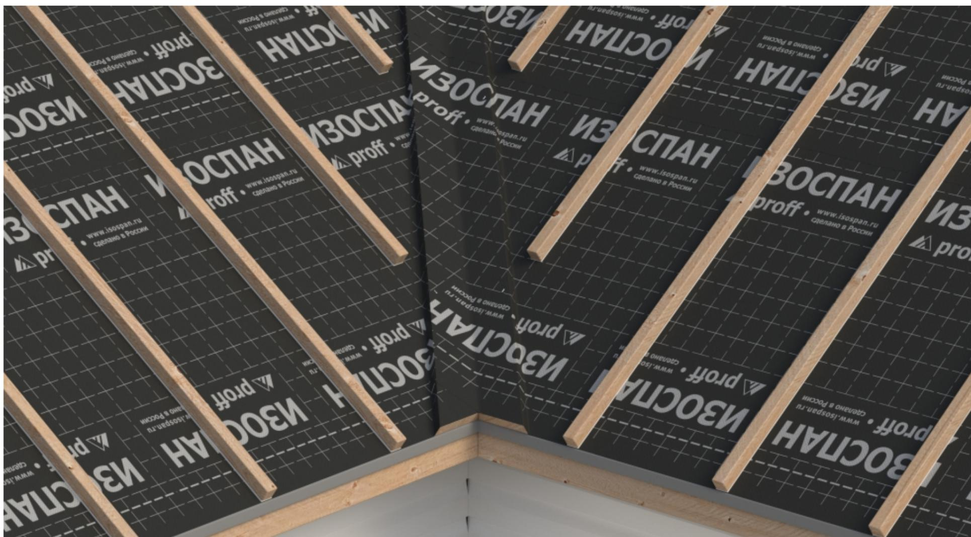
По контррейкам монтируется обрешетка или сплошной дощатый настил в зависимости от типа кровельного покрытия.
