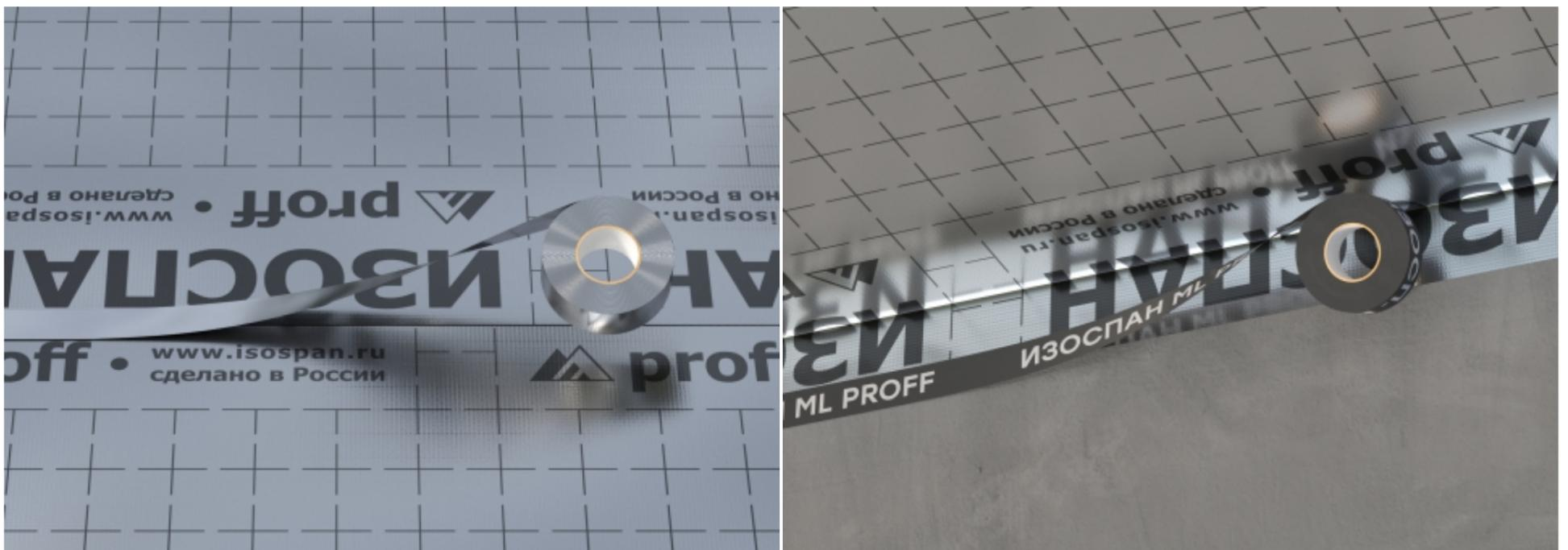
Окончательно отражающая пароизоляция / тепло-пароизоляция крепится к черновому потолку антисептированными деревянными рейками 4×5 см (при отделке помещения вагонкой, фанерой, декоративными панелями и т. д.) или оцинкованными профилями (при отделке гипсокартоном).
