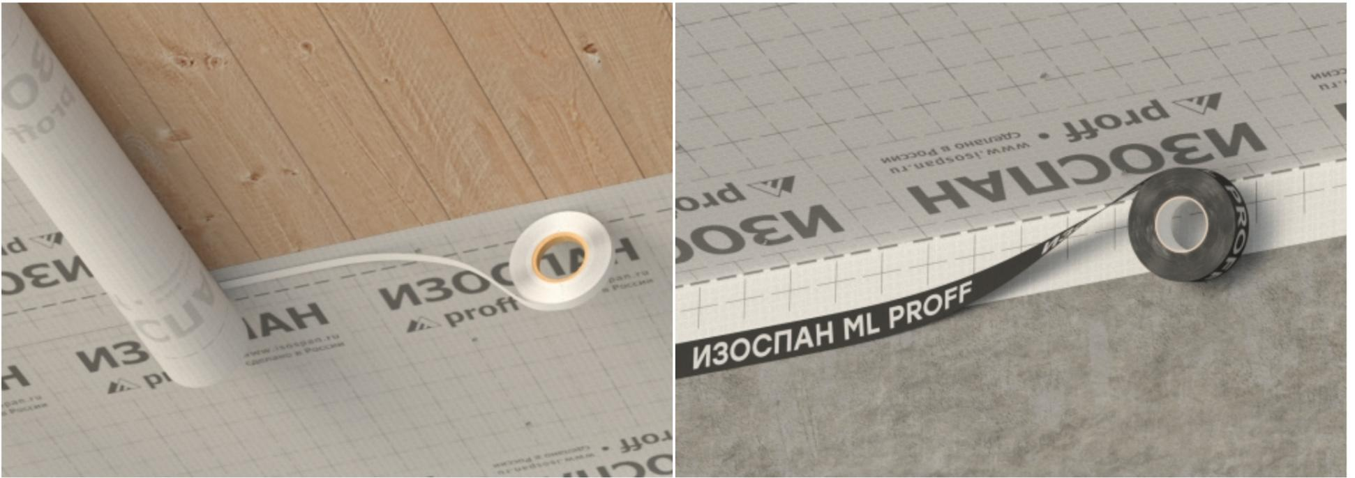
Окончательно пароизоляция крепится к черновому потолку антисептированными деревянными рейками 4×5 см (при отделке помещения вагонкой, фанерой, декоративными панелями и т. д.) или оцинкованными профилями (при отделке гипсокартоном).
