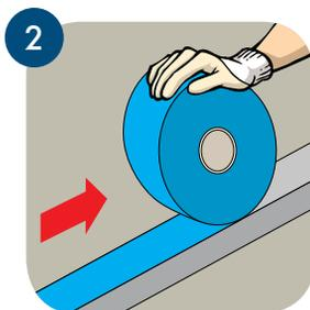
2 Наносим на наружную поверхность профилей уплотнительную ленту КНАУФ.
