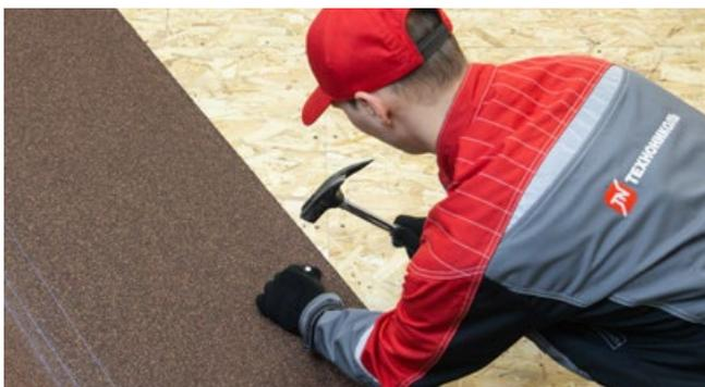
После выполнения разметки ендовы осуществляется дополнительное механическое крепление материала по боковым краям материала.
