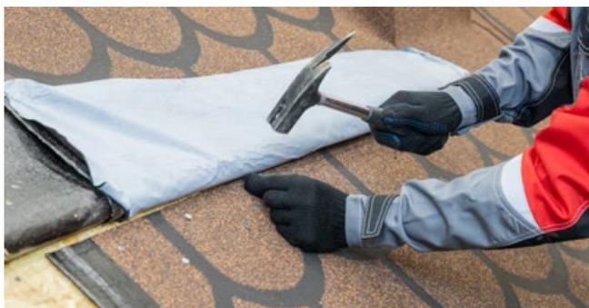
При возникновении на кровле поперечного перехлеста нижнее полотно в зоне перехлеста механически фиксируется к основанию.
