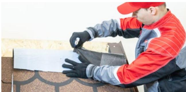
После примерки с верхней части материала частично снимается защитная пленка и материал приклеивается к поверхности.
