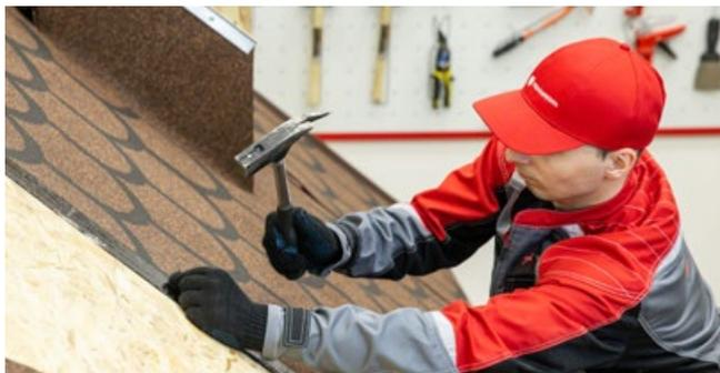
С самоклеящейся монтажной полосы удаляется защитная пленка. Перехлест фиксируется механически.
