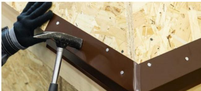
Перед установкой карнизную планку необходимо выровнять относительно края ската и произвести ее механическое крепление при помощи кровельных ершених гвоздей.
