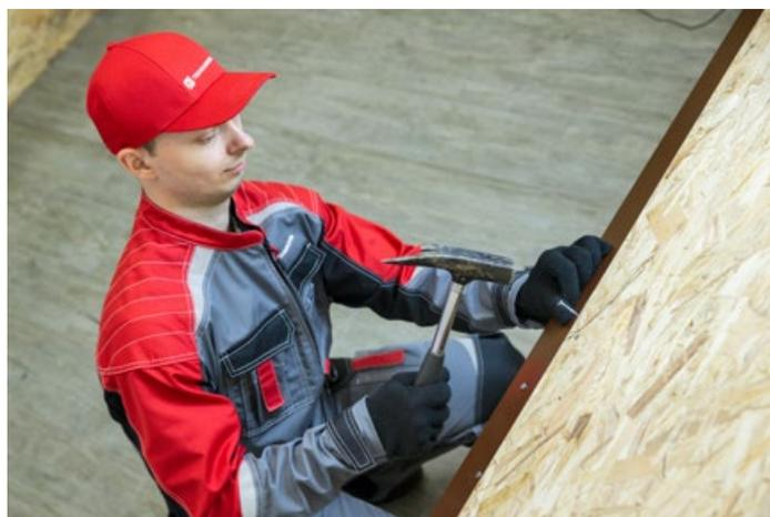
Карнизный свес кровли усиливается металлическими карнизными планками (капельниками). Они укладываются ребром на край сплошного основания и крепятся специальными кровельными гвоздями.
