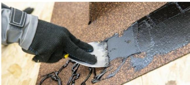
На зоны перехлестой рулонной черепицы и элементов выкровок примыкания к трубе наносится битумная приклеивающая мастика, ширина полосы нанесения не менее 100 мм. Толщина слоя мастики не более 1 мм.
