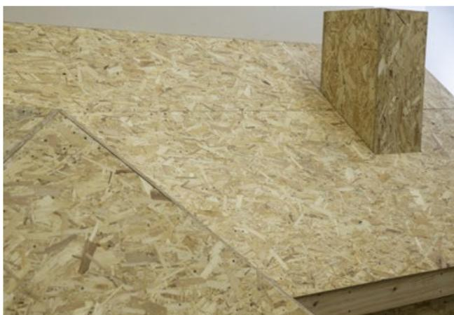
Перед началом монтажа необходимо очистить основание от мусора и пыли. Для улучшения адгезии при температуре наружного воздуха 10–15 °С, рекомендуется предварительно обработать основание битумным или латексным праймером. При использовании в качестве основания фанеры повышенной влагостойкости (ФСФ) перед монтажом материала поверхность праймируется в обязательном порядке.
