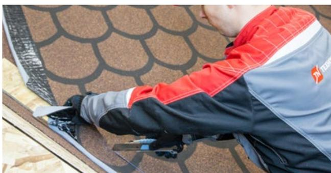
При монтаже материала в зоне ендовы осуществляется его примерка, разметка. Материал подрезается по линии формирования желоба ендовы.
