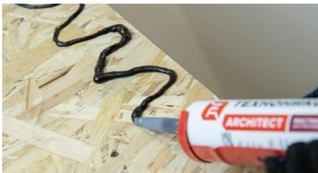
Фронтонный свес кровли усиливается металлическими торцевыми планками. Перед монтажом на места размещения торцевых планок необходимо нанести битумную мастику.
