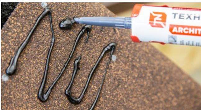
Для монтажа следующего элемента на место перехлеста элементов наносится битумная приклеивающая мастика.
