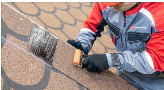
Смонтированный элемент дополнительно прокатываются прикаточным роликом.
