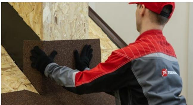
Загибаем части выкроек на боковые стороны и удаляем оставшуюся силиконизированную пленку с материала.
