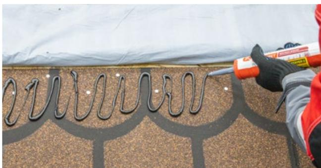
На механически зафиксированное нижнее полотно материала наносится битумная приклеивающая мастика.
