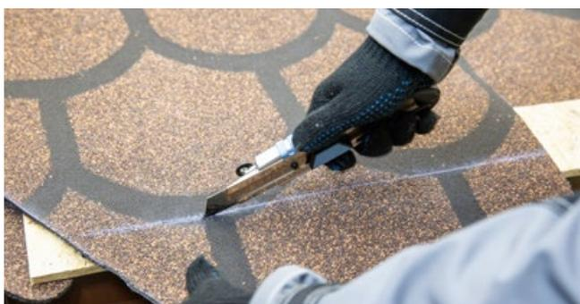
Чтобы не повредить уже смонтированное покрытие при обрезке материала подкладываем под поверхность твердое основание.
