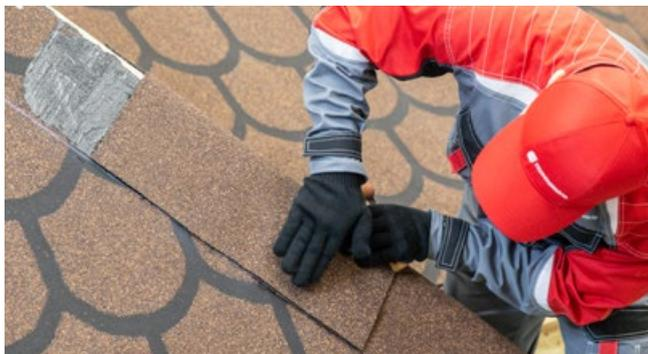
Далее в нахлест укладывается следующий элемент выкройки. Монтаж элементов выполняется снизу вверх, так чтобы верхнее полотно материала находило на нижнее.
