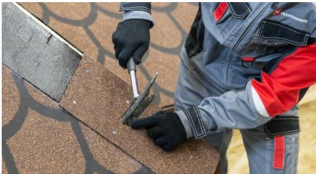
Уложенный элемент дополнительно механически фиксируется к поверхности при помощи кровельных ершених гвоздей по 4 шт. на каждую сторону.
