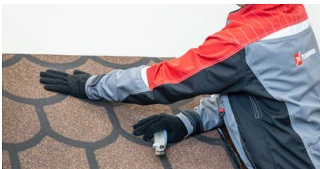
После выполнения замеров необходимо примерить материал по месту, выровнять его на поверхности кровли.
