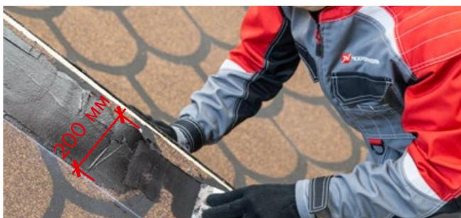
В зоне формирования реберных элементов наносится битумная мастика, ширина нанесения минимум 200 мм. Толщина слоя битумной мастики не более 1 мм.
