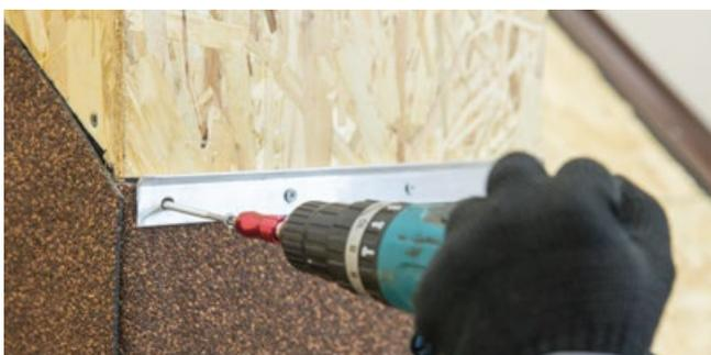
Коньково-ендовый ковер смонтированный на вертикальную поверхность дополнительно фиксируется прижимной кровельной планкой. На верхнюю часть прижимной кровельной планки наносится кровельный герметик, после чего планка дополнительно закрывается металлическим отливом.
