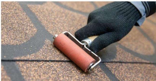
Место перехлеста дополнительно прокатывается прикаточным роликом.
