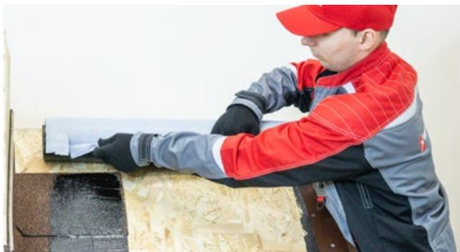
Частично зафиксированная сверху полоса материала раскручивается сверху вниз, при этом с самоклеящегося слоя полностью удаляется защитная селенозированная пленка.
