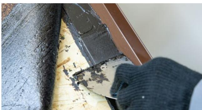
Перед монтажом рулонной черепицы на торцевые и карнизные планки, на последние наносится битумная мастика, после чего материал приклеивается к основанию.
