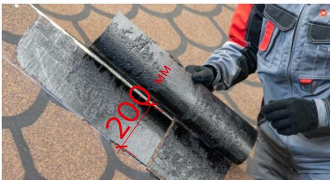
Перехлест реберного элемента на обе стороны составляет минимум 200мм. Толщина слоя битумной мастики не более 1мм.
