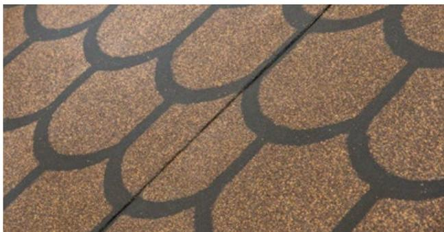
Монтаж следующего рулона на поверхность производится с учетом геометрии рисунка, необходимо совместить рисунок в месте перехлеста рулонов.
