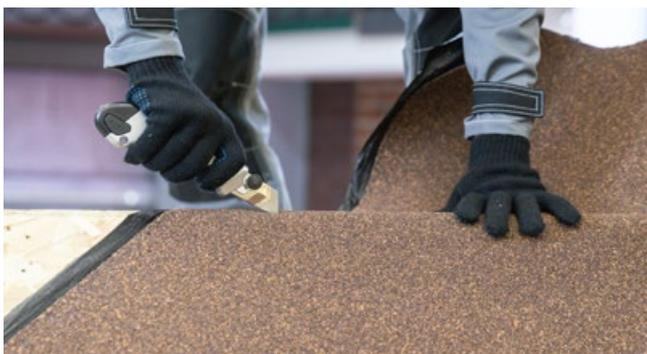
В зоне ребер кровли и в зоне карнизной планки осуществляется подрезка материала.
