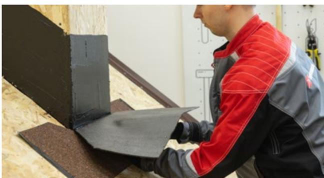
Защитная пленка удаляется и осуществляется крепление материала к вертикальной поверхности. Минимальная высота заведения на вертикальную поверхность 300 мм.
