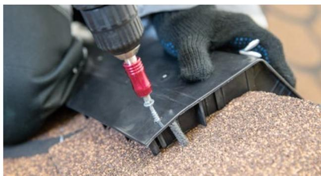
При устройстве в коньке кровли вентиляции для проветривания подкровельного пространства в случае с устройством мансарды осуществляется крепление конькового аэратора к основанию. Под коньковый аэратор делается зазор в сплошном основании кровли шириной 5–10 см.
