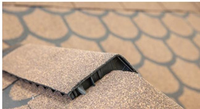
Сверху на коньковый аэратор осуществляется крепление элементов коньково-ендового ковра. Выкройка укладывается на пластиковый элемент без применения приклеивающей мастики. Нижнее полотно материала в зоне перехлеста крепится к основанию удлиненными кровельными гвоздями по 4 шт. с каждой стороны ската и отступом от края полотна 20мм. Места элементов промазываются битумной приклеивающей мастикой. Итоговый вид кровли из Рулонной черепицы ТЕХНОНИКОЛЬ.
