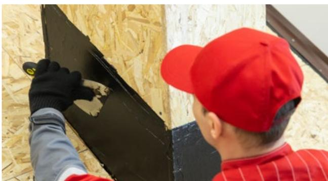
После этого на вертикальную поверхность трубы наносится битумная приклеивающая мастика.
